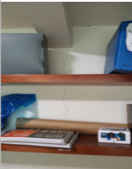
FISSURA PAREDE
