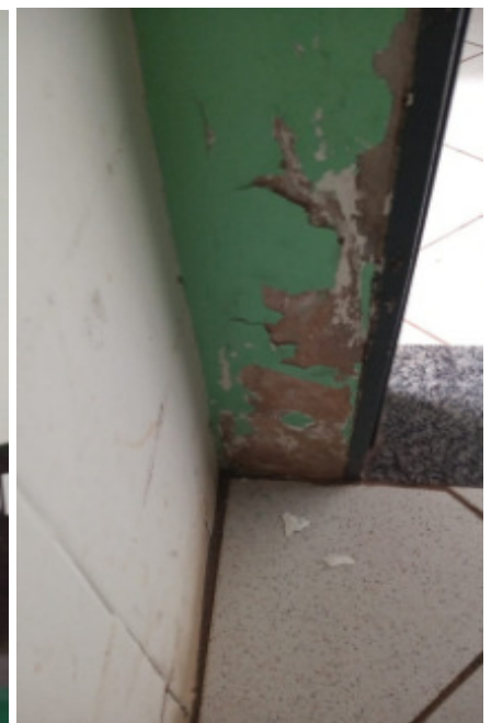
PINTURA DESCASCANDO
