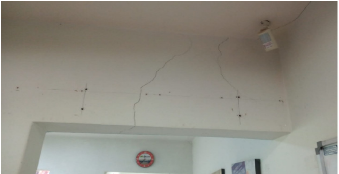
FISSURA PAREDE/TETO
