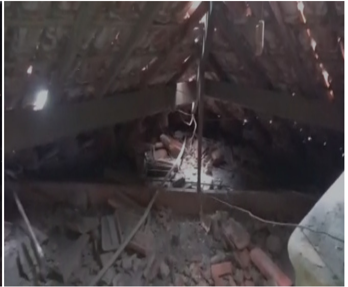
TELHA QUEBRADA/AUSENCIA DE TELHA
