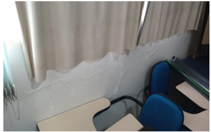
FISSURA/INFILTRAÇÃO PAREDE
