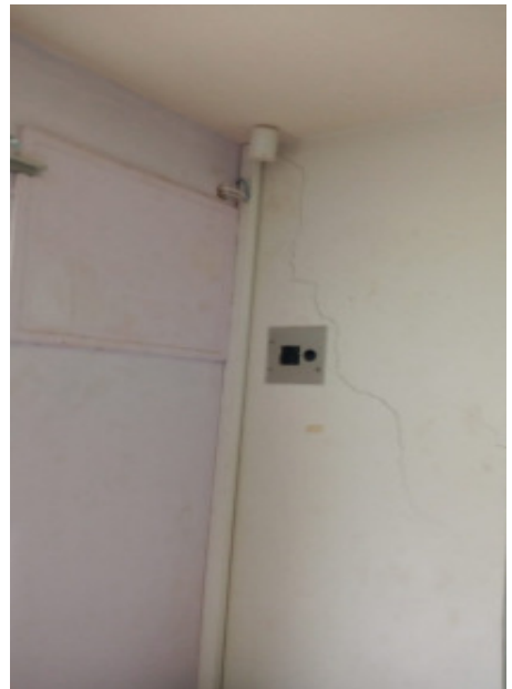
FISSURA PAREDE
