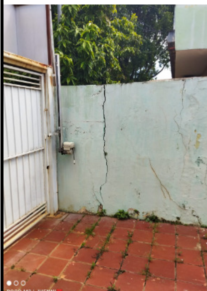
MURO COM RACHADURA
