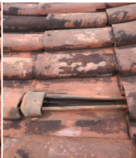
TELHA QUEBRADA/AUSENCIA DE TELHA
