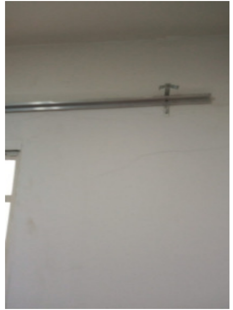
FISSURA PAREDE
