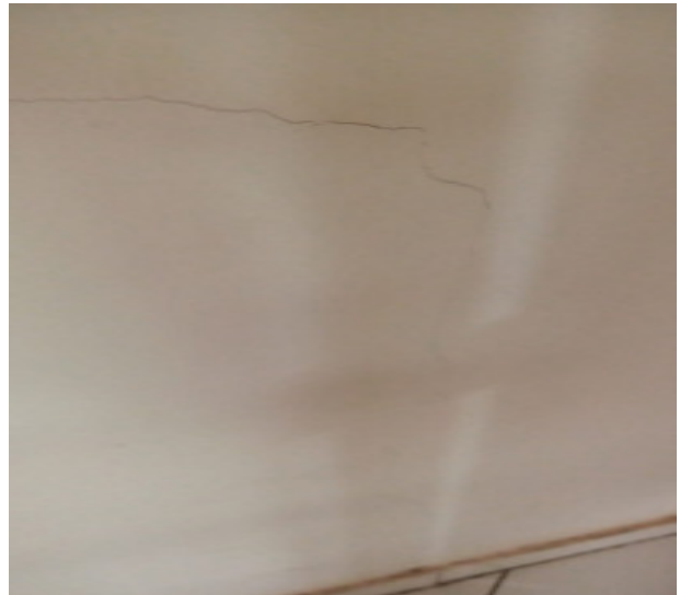
FISSURA PAREDE
