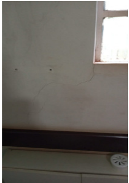
FISSURA/INFILTRAÇÃO
