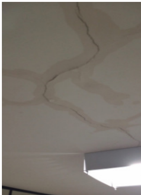
FISSURA/INFILTRAÇÃO TETO
