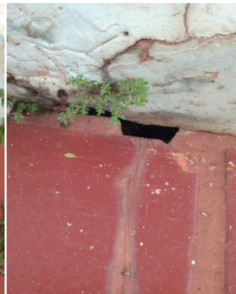
RECALQUE UMIDADE
