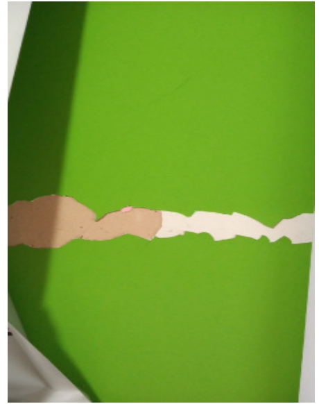
PINTURA DESCASCANDO
