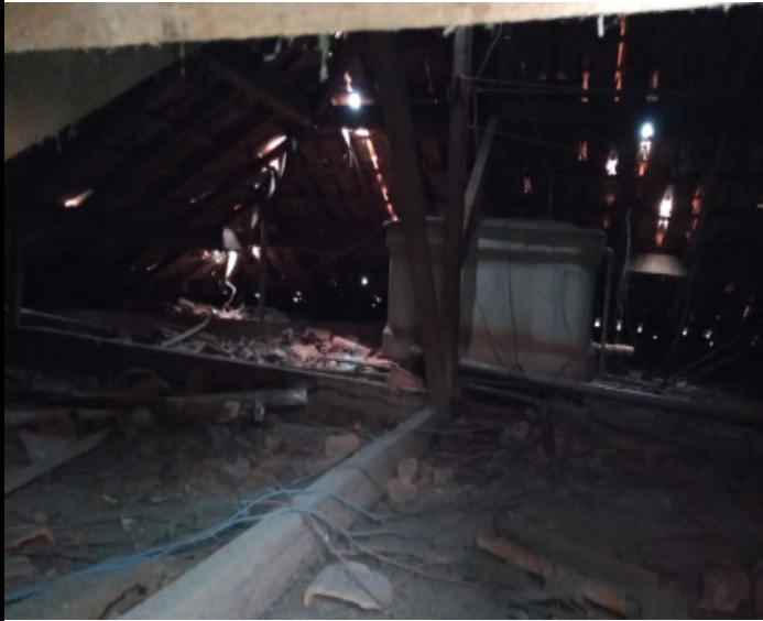
TELHA QUEBRADA/AUSENCIA DE TELHA
