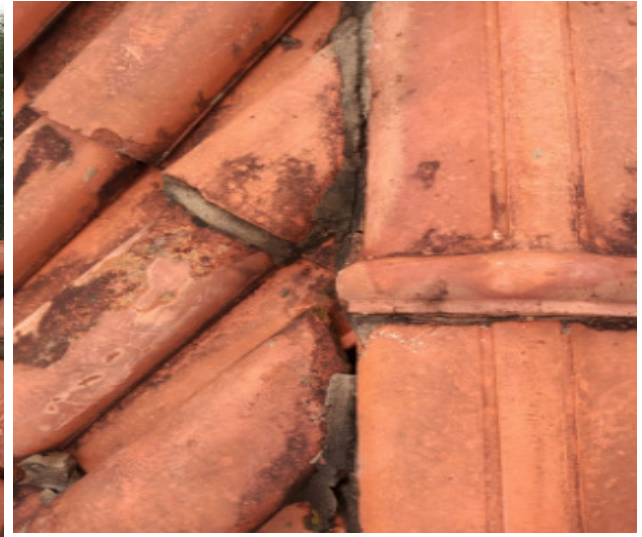
TELHA SOLTA/QUEBRADA
