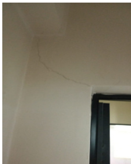
FISSURA PAREDE
