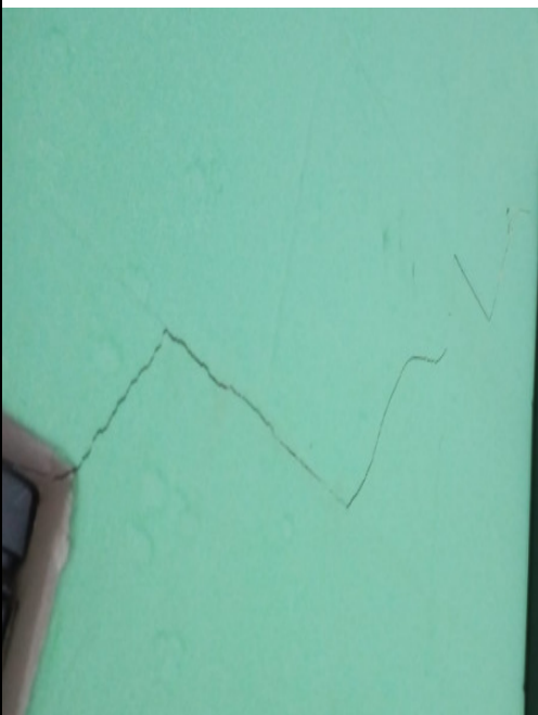
FISSURA PAREDE
