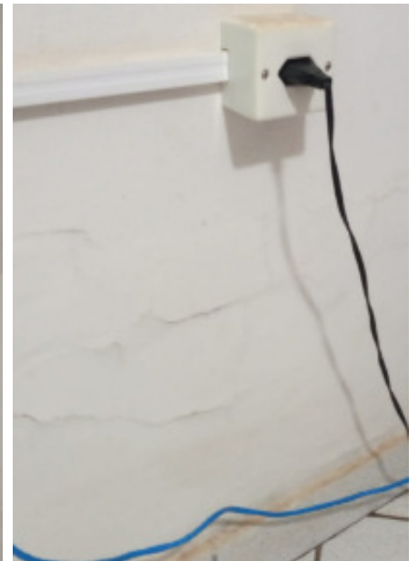
PINTURA DESCASCANDO
