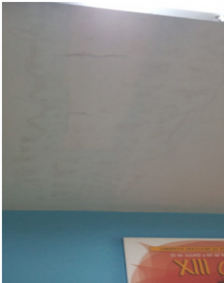
INFILTRAÇÃO TETO
