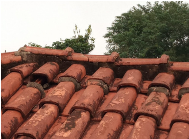
TELHA SOLTA/QUEBRADA
