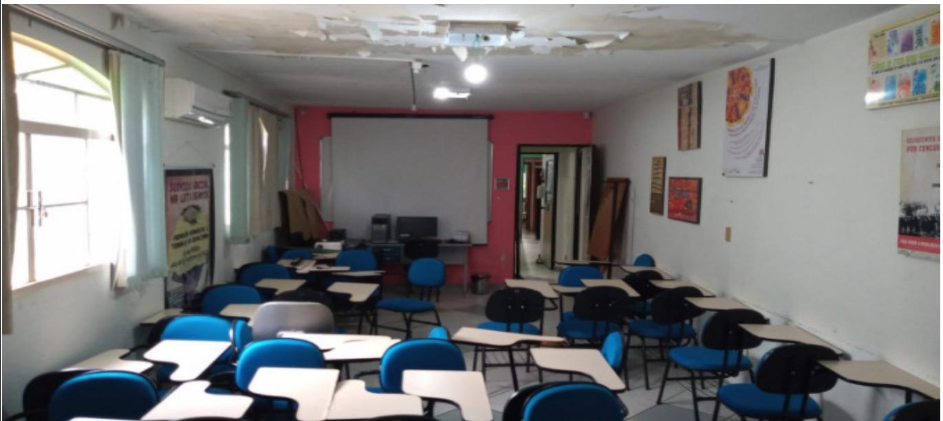
FISSURA/INFILTRAÇÃO
