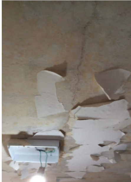
FISSURA/INFILTRAÇÃO TETO
