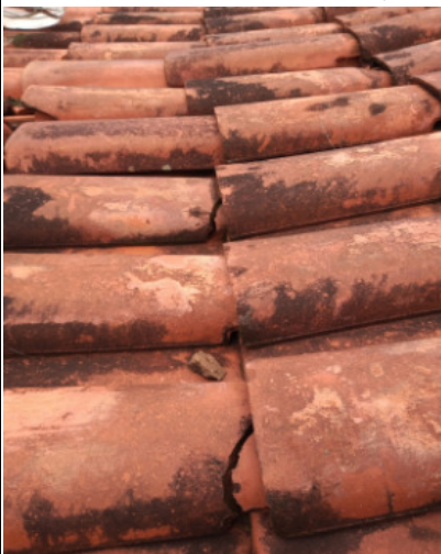
TELHA SOLTA/QUEBRADA
