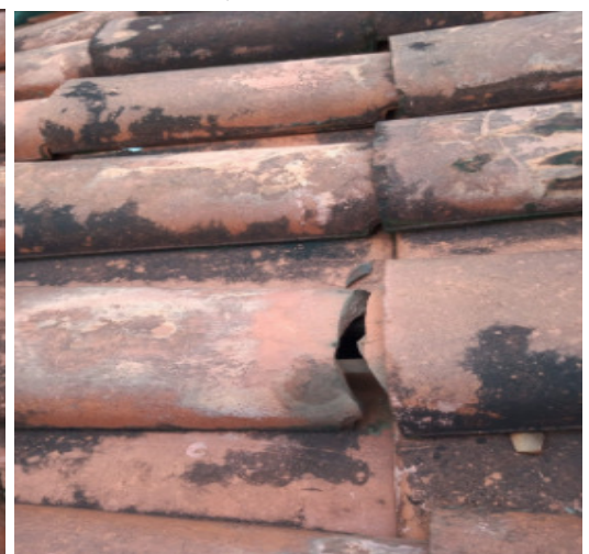
TELHA SOLTA/QUEBRADA
