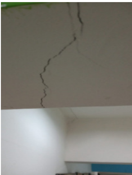
FISSURA PAREDE
