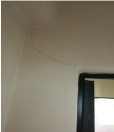
FISSURA PAREDE
