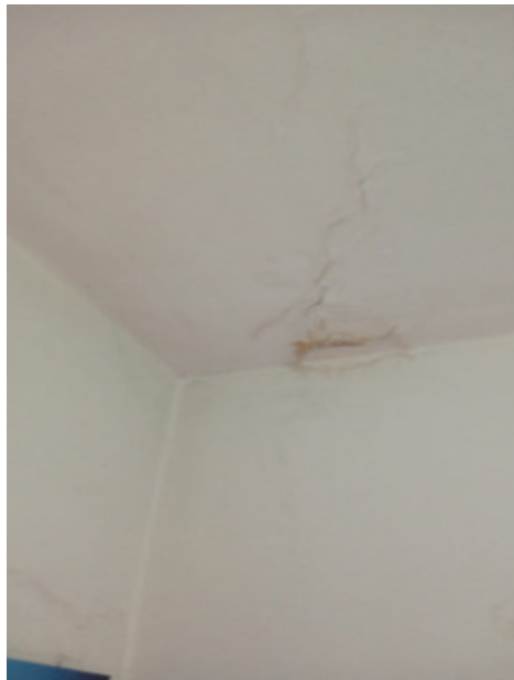
FISSURA/INFILTRAÇÃO
